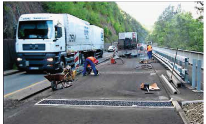
Abbildung 2: Fahrstreifenweiser Einbau eines Fahrbahnübergangs aus Asphalt unter laufendem Verkehr.
